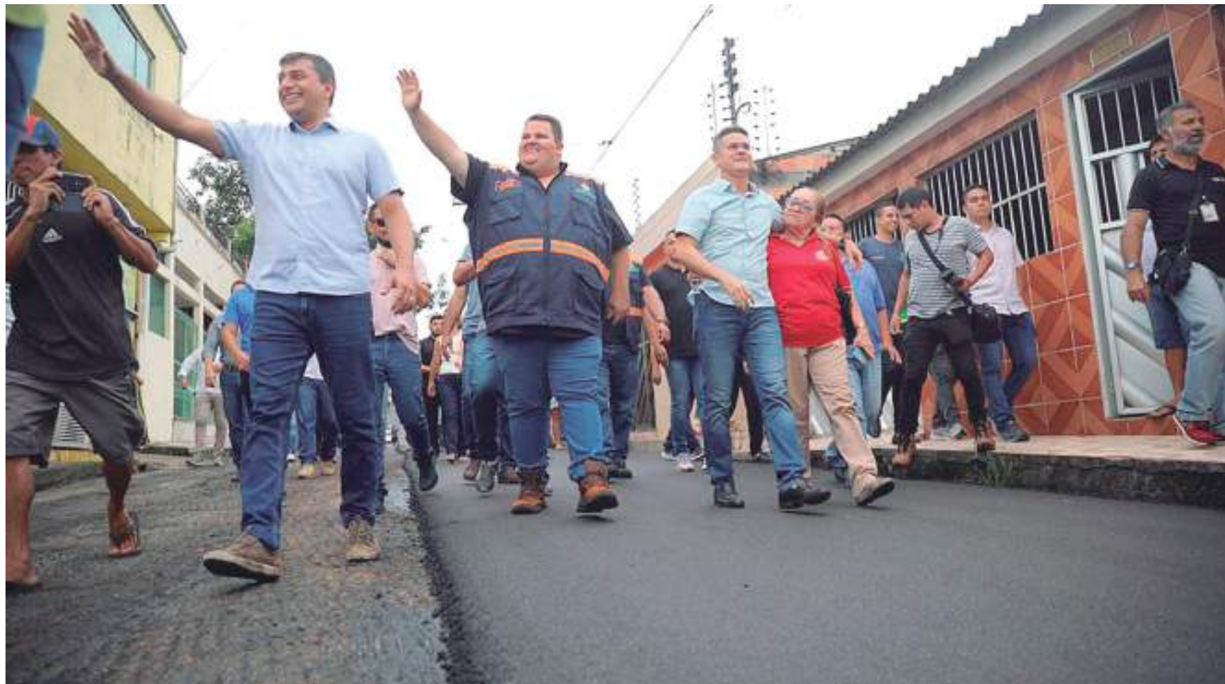
Serviços fazem parte de mais uma frente de obras do 'Asfalto Manaus'
