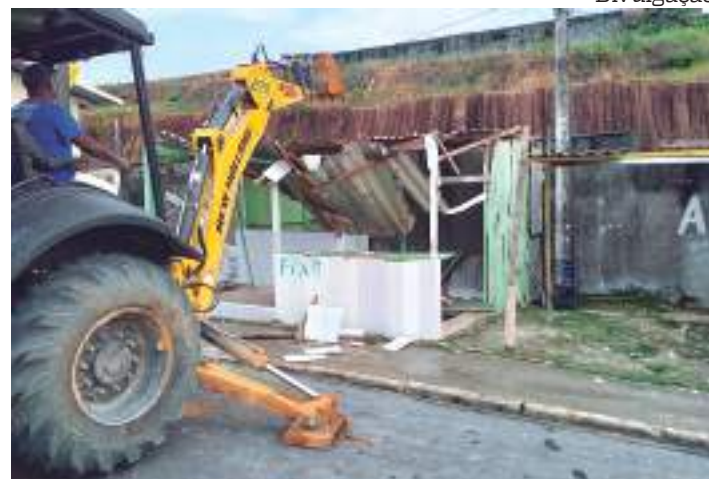
Demolições foram realizadas por conta das ocupações irregulares nas vias
