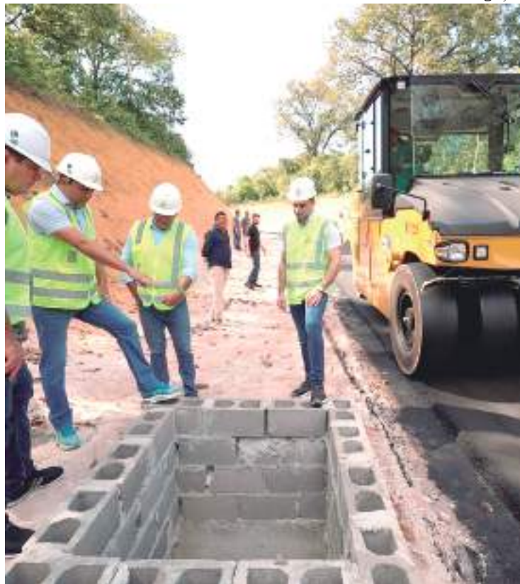
Wilson vistoria início do asfaltamento do viaduto do Anel Leste
