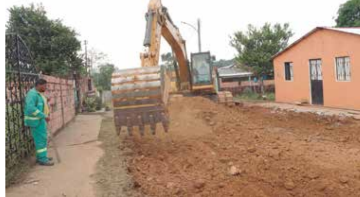
Ao todo, as obras somam um investimento de R$ 15,2 milhões
