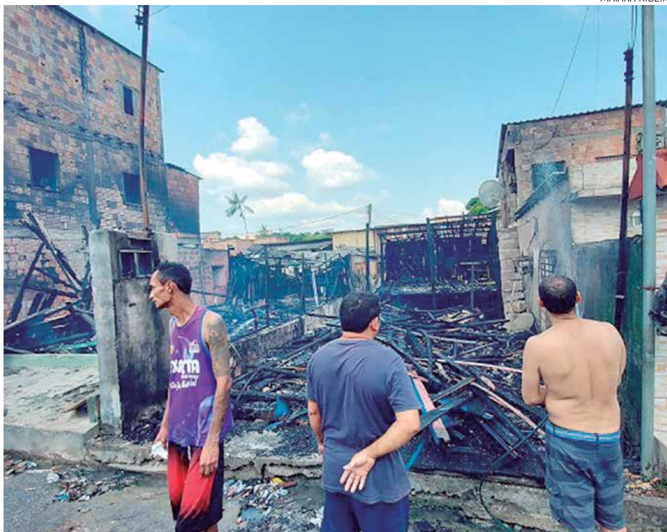
Três residências de madeira e três de alvenaria foram atingidas no incêndio que aconteceu ontem [27]
