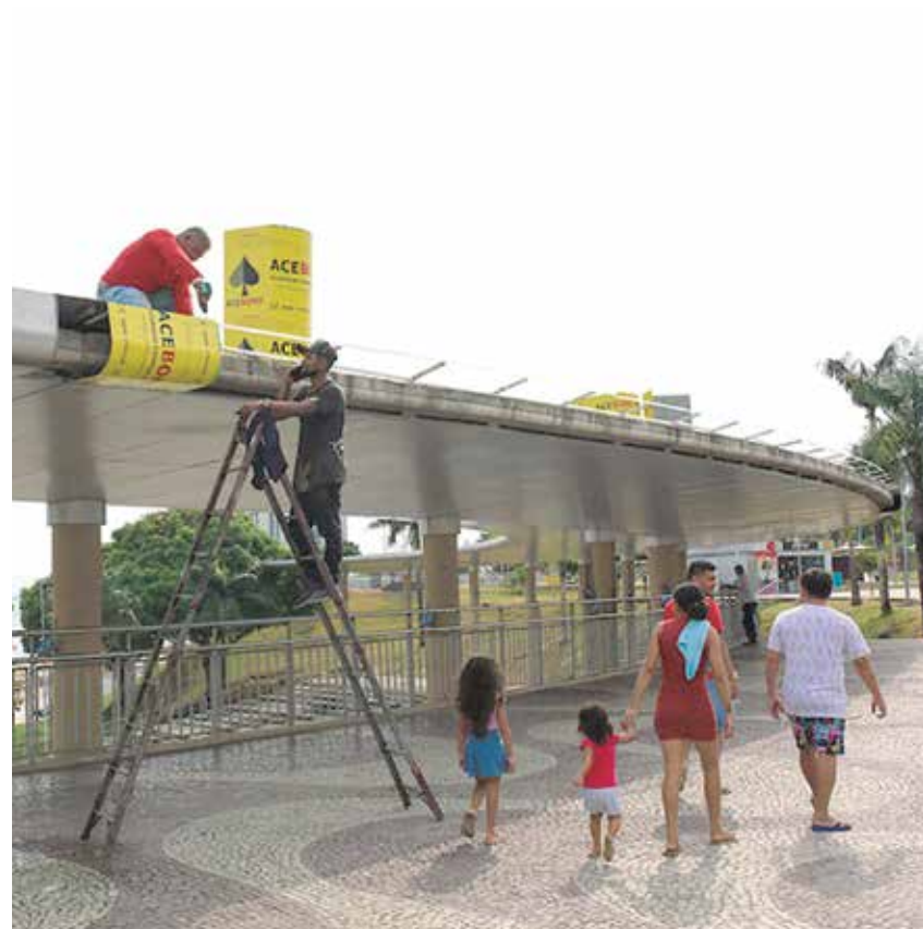
Serviços de manutenção se concentram no anfiteatro do complexo turístico
