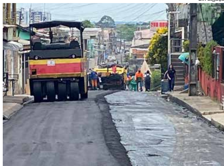
Ruas do bairro Compensa recebem recapeamento asfáltico da Seminf
