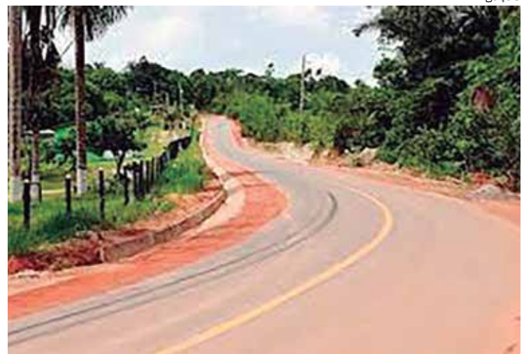
Pavimentação do ramal Sullivan Portela atingiu 55% de execução
