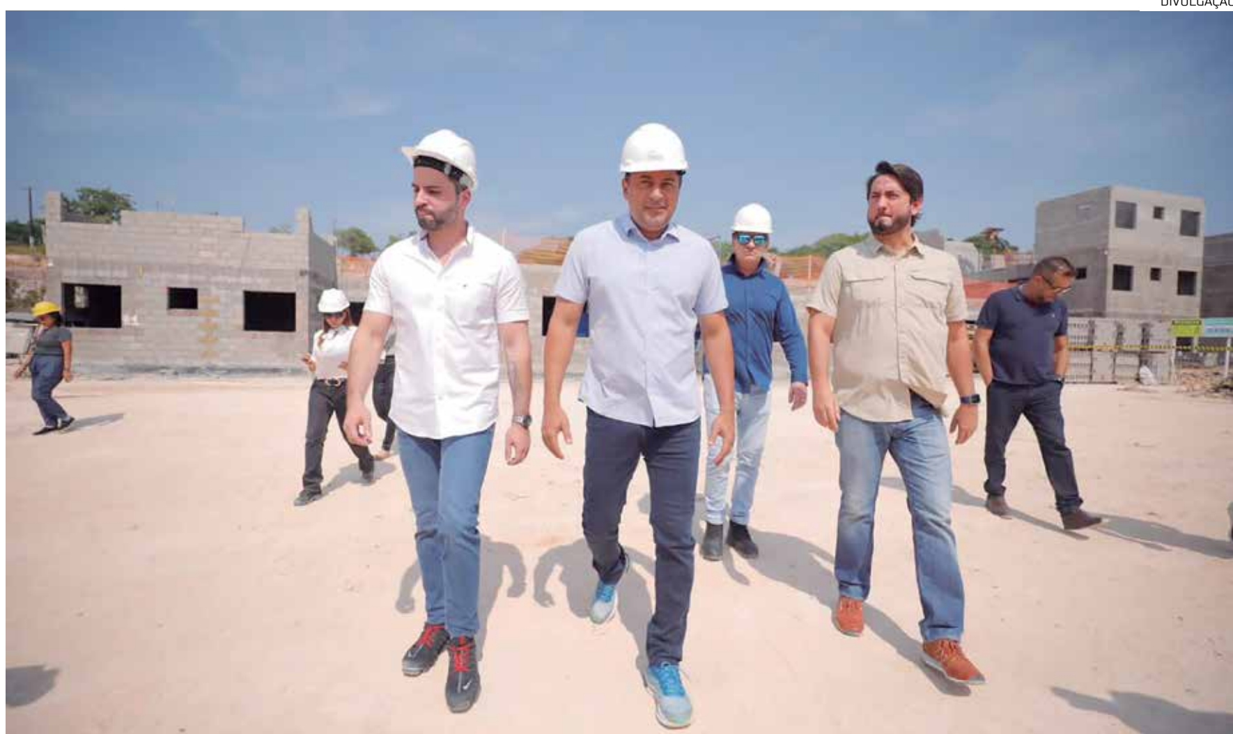
Atualmente as obras do residencial empregam 65 pessoas diretamente
