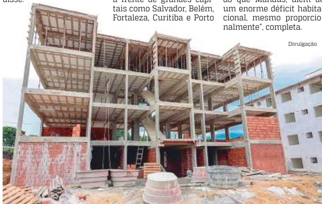
Obra na cidade de Manaus, indicada como quarta melhor cidade para investimentos imobiliários
