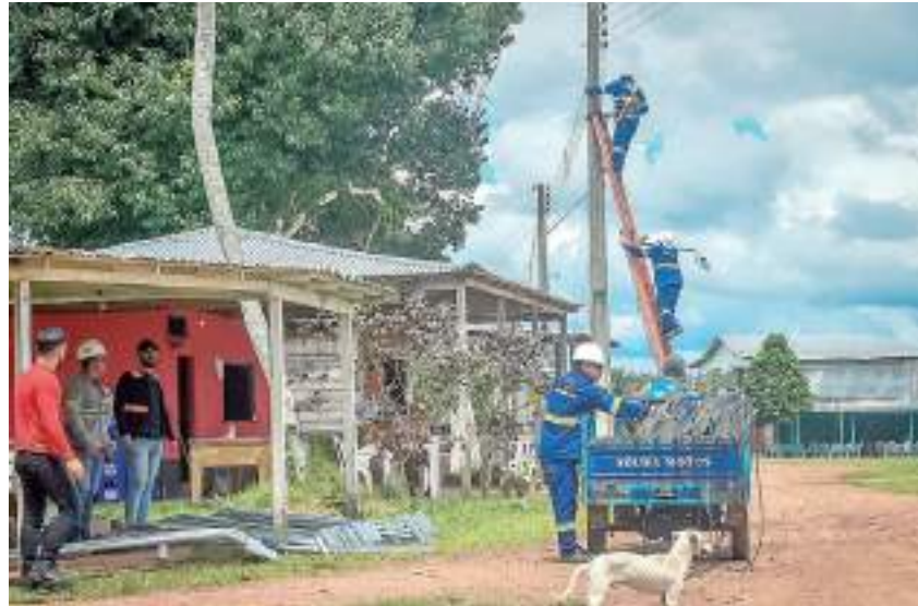
Trabalhadores instalam nova iluminação na comunidade rural de Nazaré
