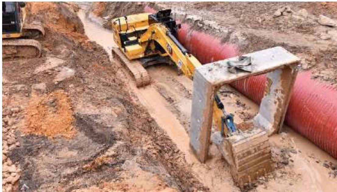
Obra troca as tubulações para que o igarapé do Bindá atravesse a avenida Djalma Batista sem problemas
