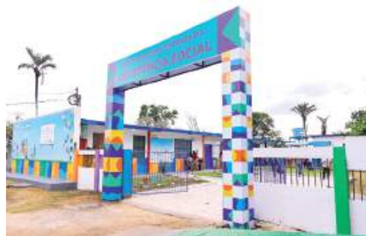
Entrada do revitalizado Cras Antônio Aleixo em Manaus
