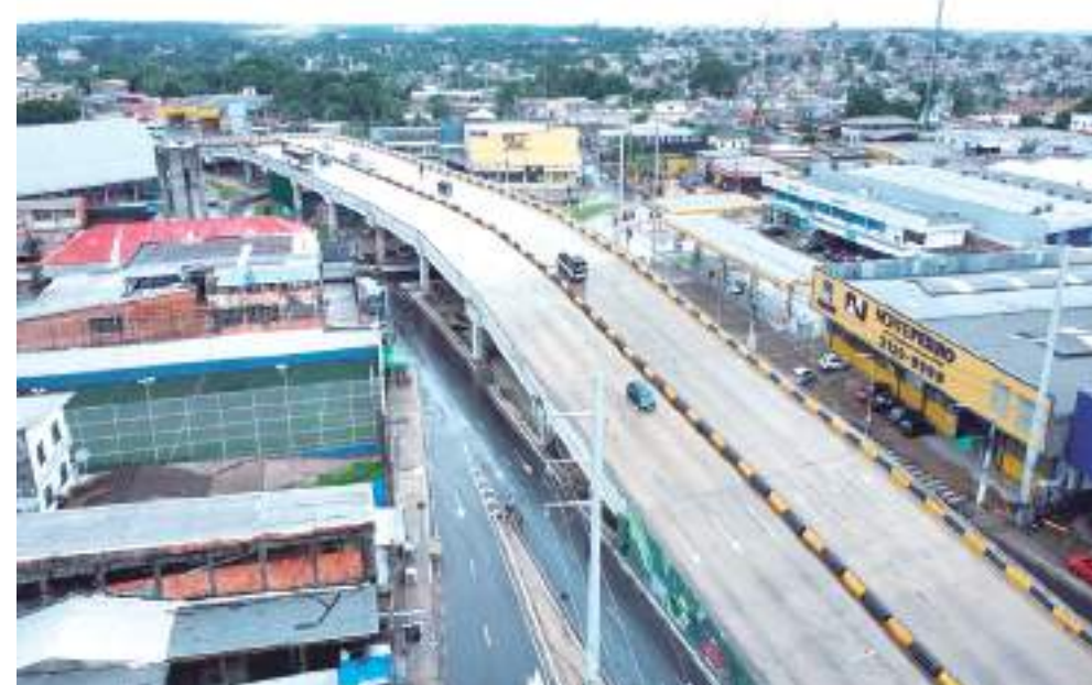
Viaduto do Manoa passa por interdição para reparos de pequenas anomalias
