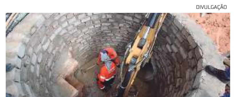
Seminf atua na implantação de novas redes de drenagem profunda
