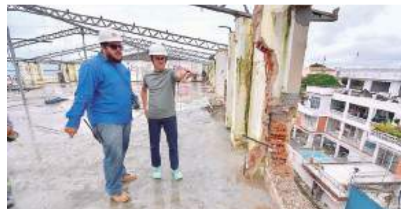
David Almeida vistoria o avanço das obras do programa "Nosso Centro"
