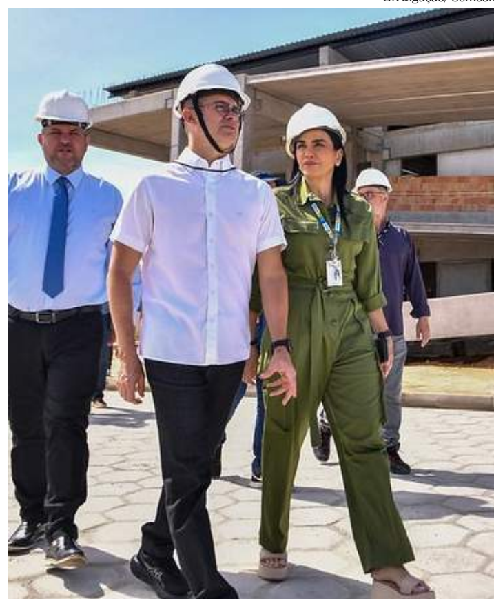
David Almeida vistoria obras da UBS no conjunto Viver Melhor 3
