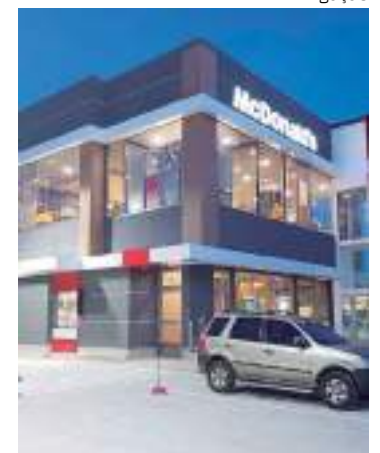
Restaurante McDonald's na avenida Djalma Batista
