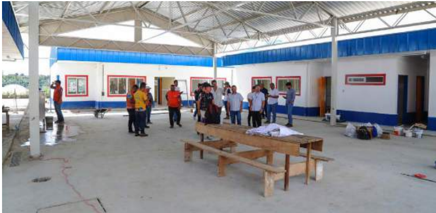
Prefeito David Almeida fiscaliza a fase final das obras da creche municipal
