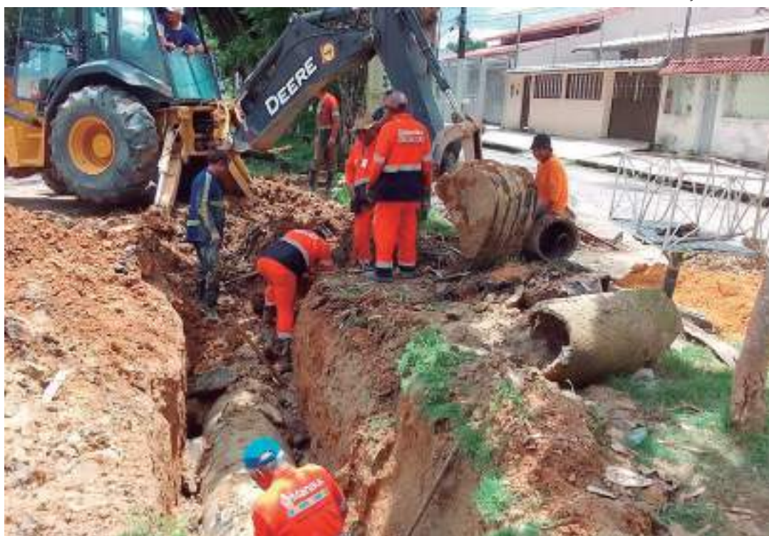
Equipes da Seminf atuaram em redes danificadas e obstruídas
