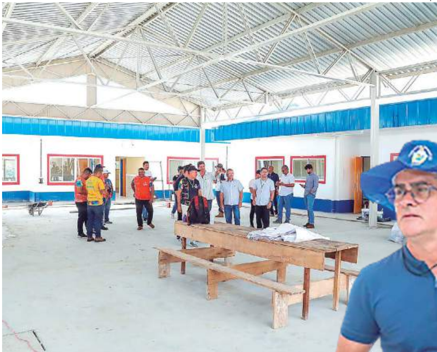
Prefeito David Almeida fiscaliza a fase final das obras da creche municipal
