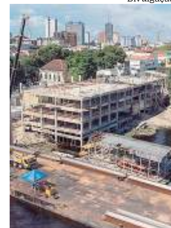
Prefeitura de Manaus iniciou a montagem das lajes para steel deck
