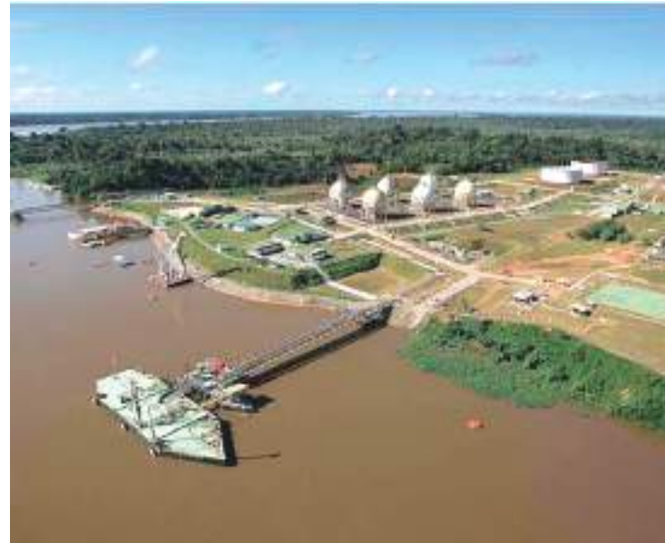
Vista aérea do gasoduto Urucu-Coari-Manaus
