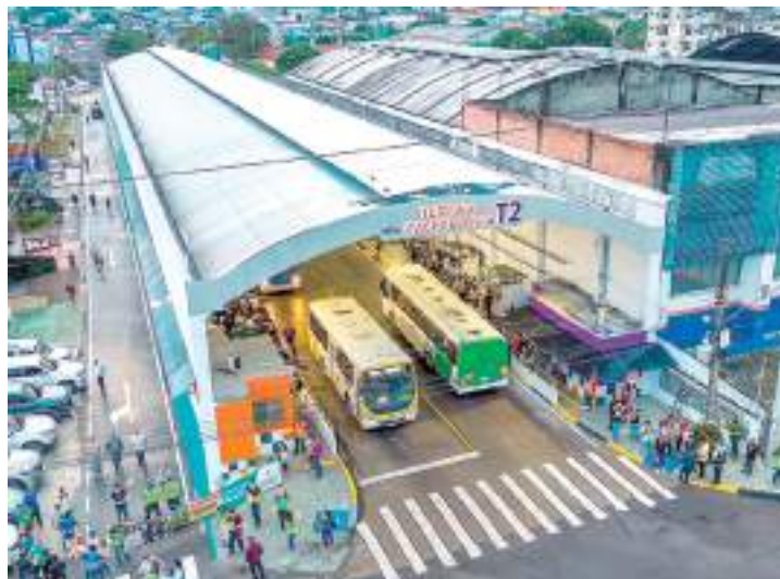
Terminal 2 recebe câmeras de segurança após revitalização
