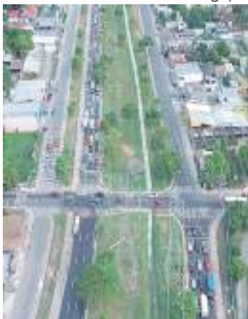
Trecho que terá obras
