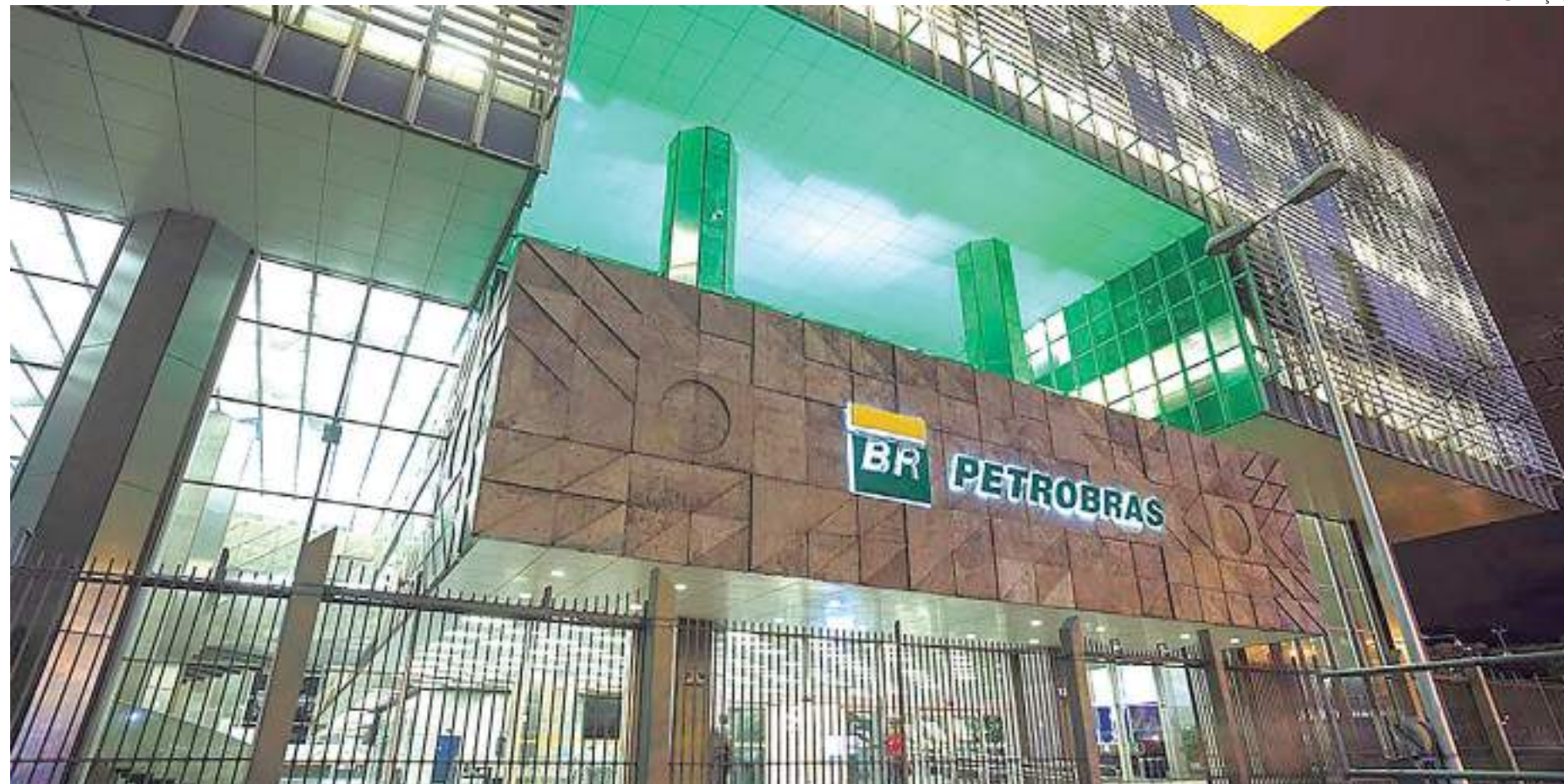
Fachada da Petrobras
