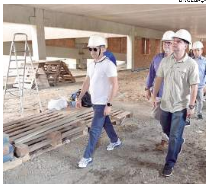
Obra da UBS porte 4 na Zona Norte da capital
