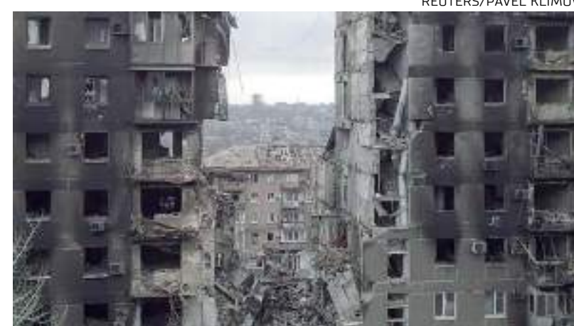
Prédio destruído em Mariupol, na Ucrânia
