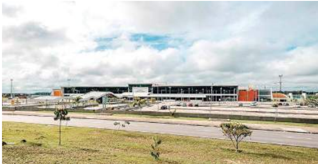
Fachada aeroporto de Manaus
