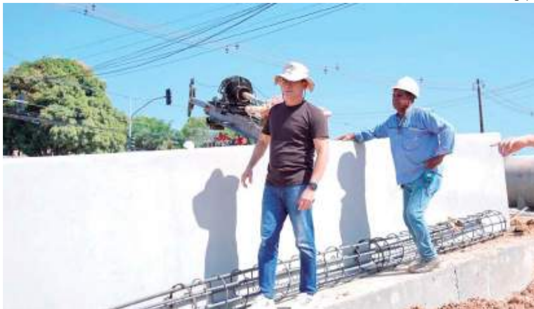
David Almeida vistoria obra que será entregue seis meses antes do prazo original
