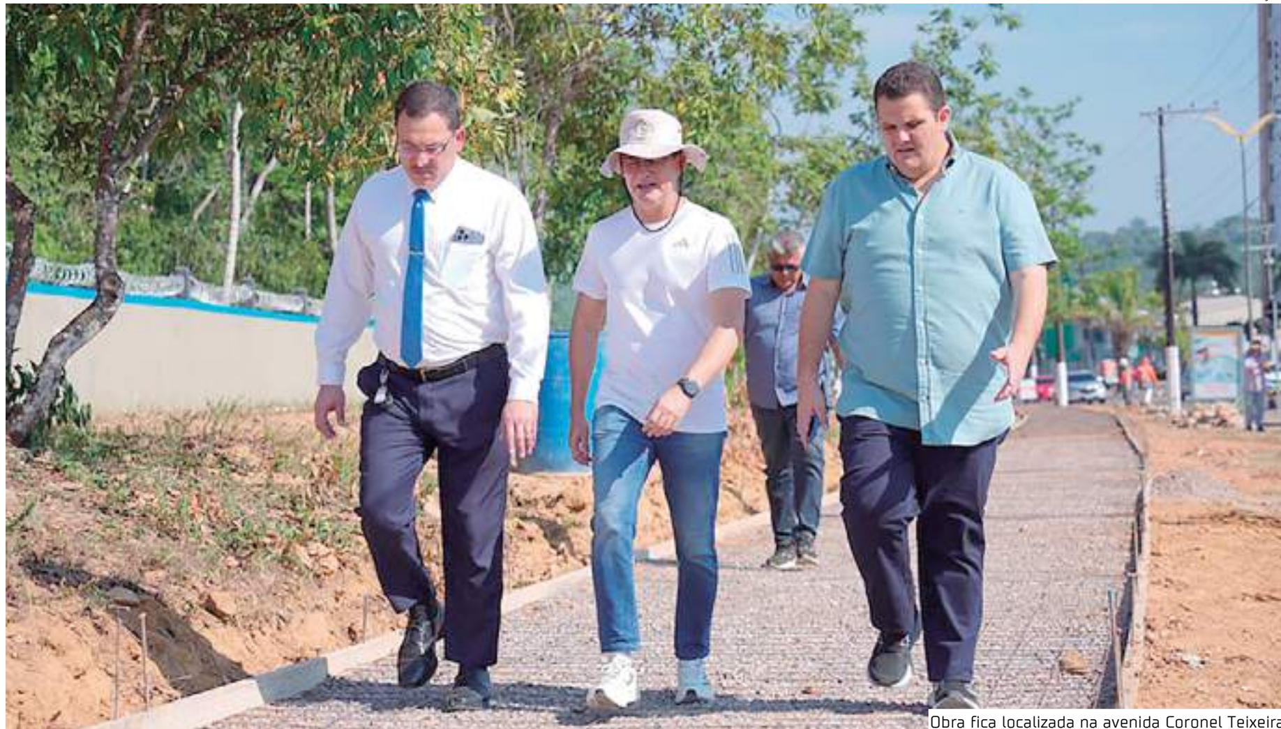
Obra fica localizada na avenida Coronel Teixeira
