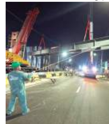
Obra já está 80% concluída
