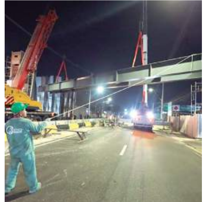
Avenida é interditada para montagem de cobertura da passarela
