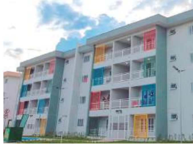
Empreendimento habitacional construídos pelo programa
