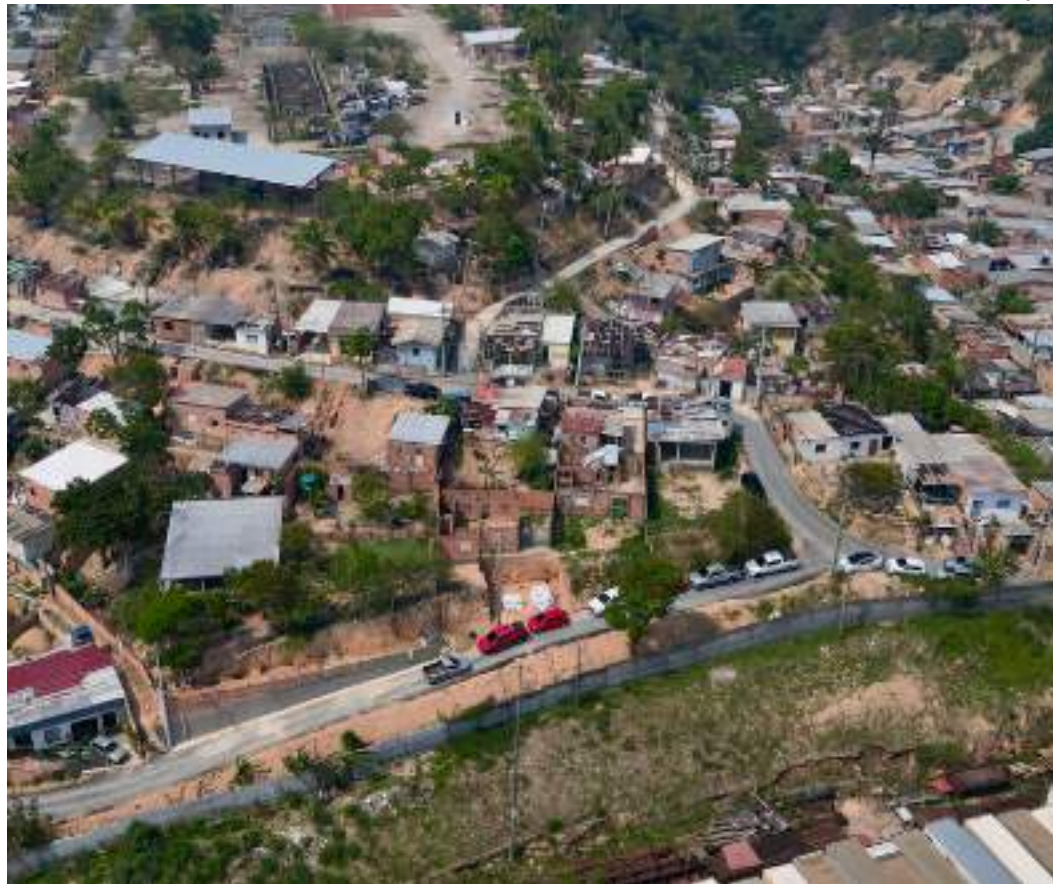
Ao todo onze ruas da comunidade foram beneficiadas com pavimentação
