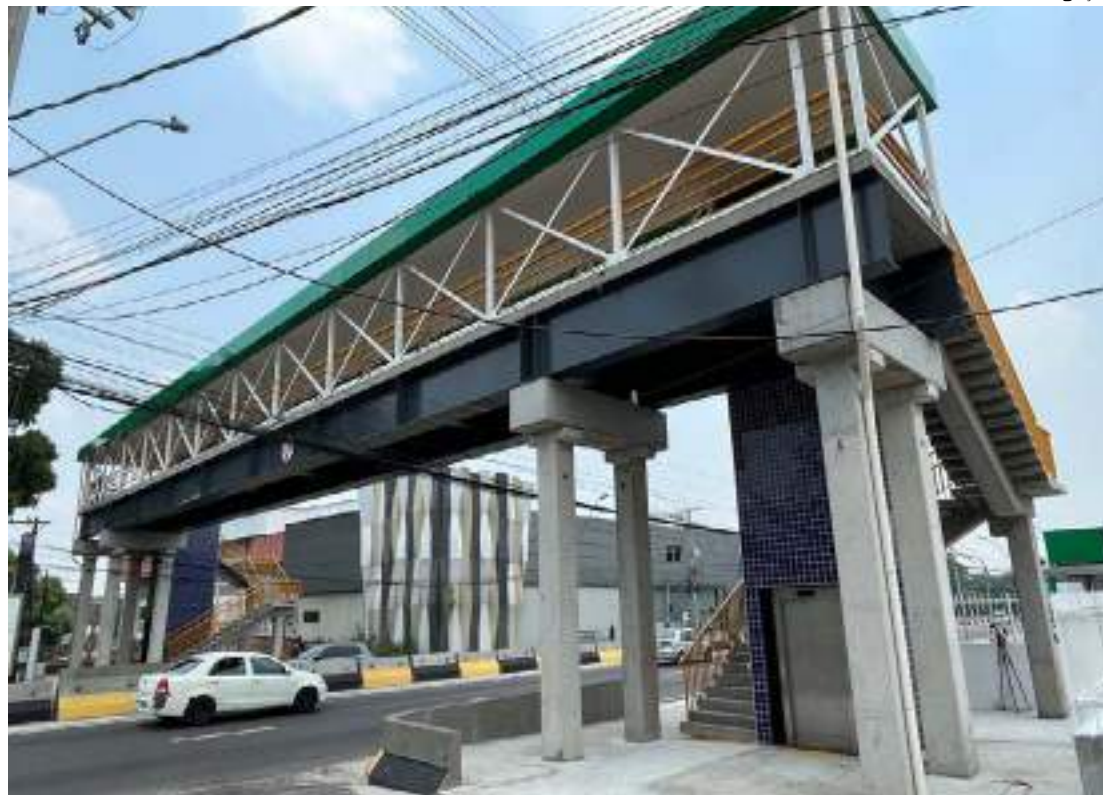
Estrutura metálica moderna garante segurança aos pedestres
