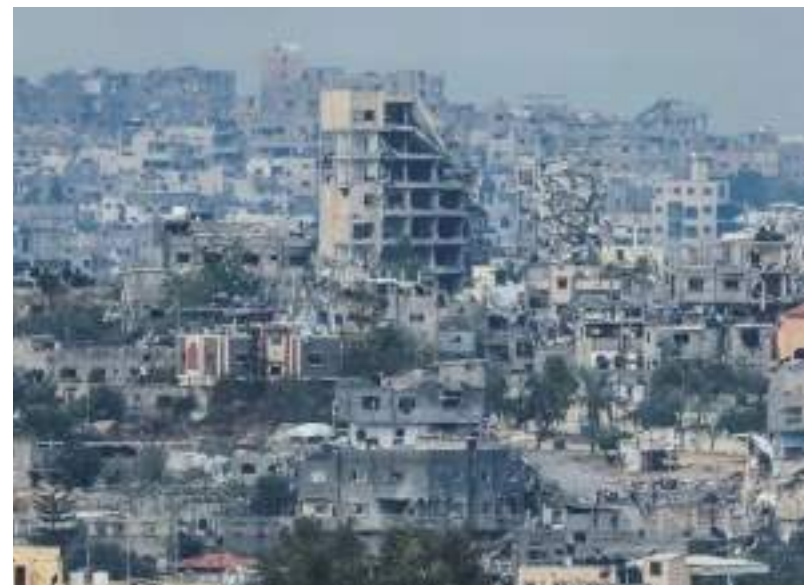
Prédios destruídos por ataques israelenses em Gaza
