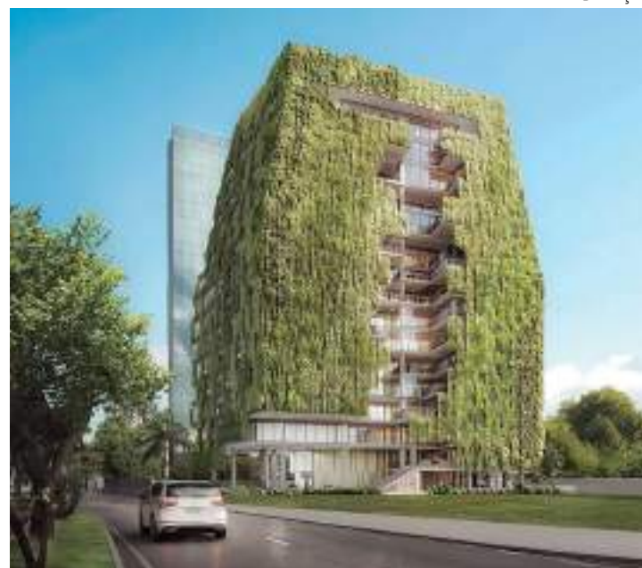
Botânica Office está sendo erguido em Manaus
