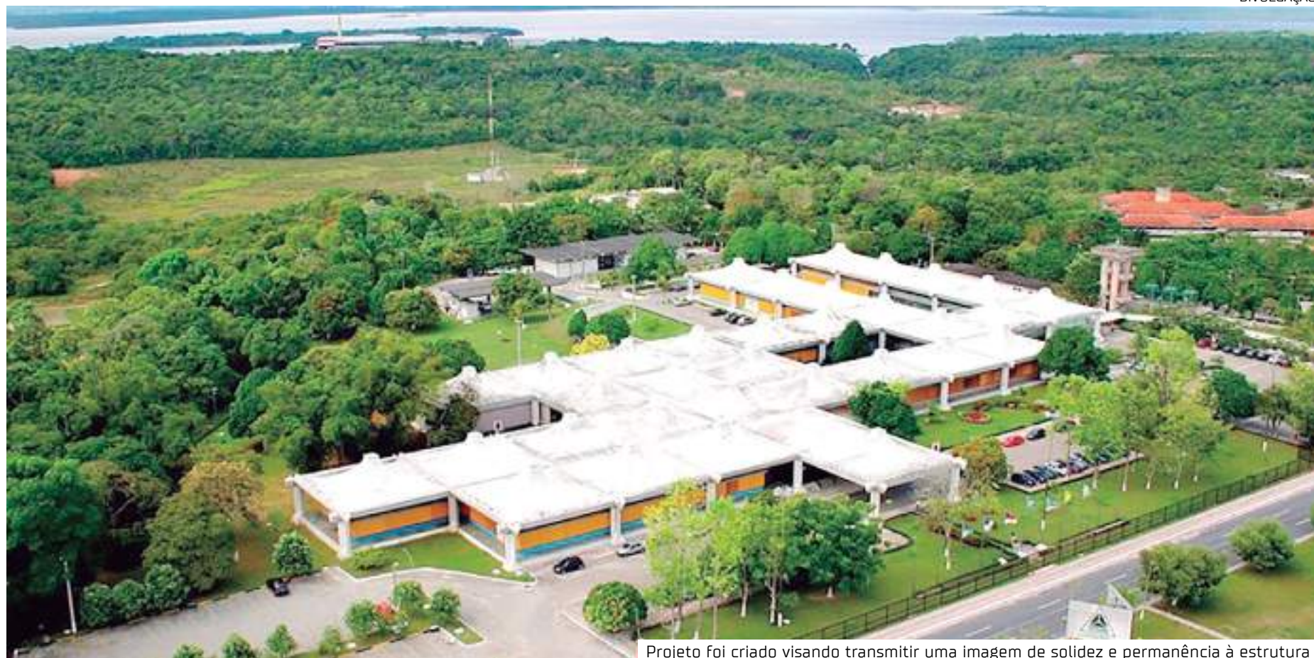
Projeto foi criado visando transmitir uma imagem de solidez e permanência à estrutura
