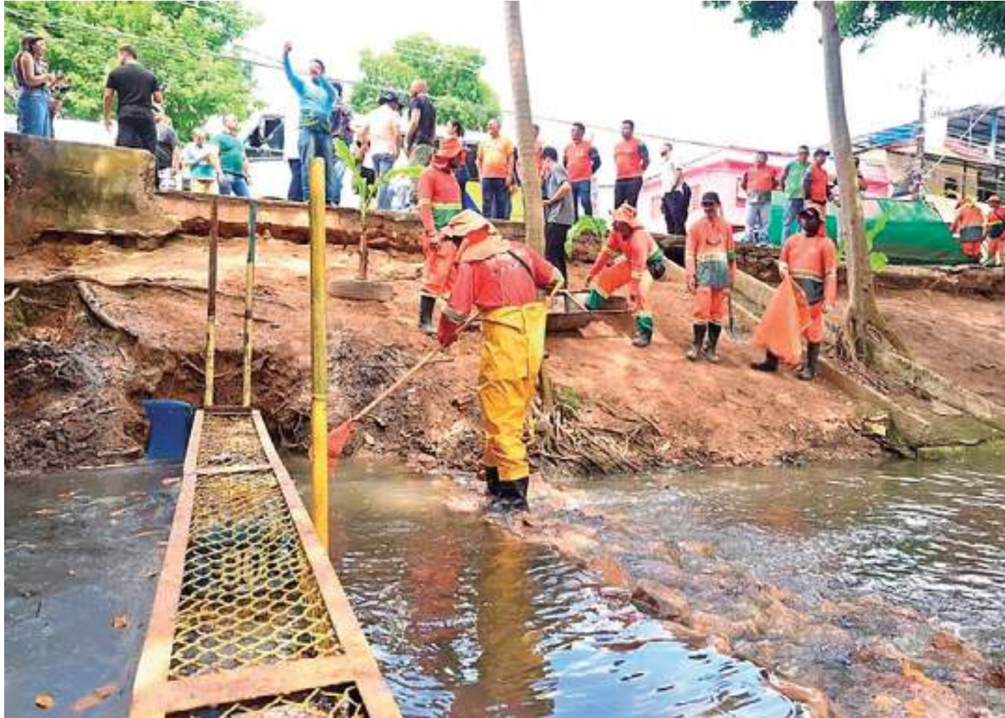
Área no entorno do igarapé também será totalmente reestruturada com serviços executados por meio da Seminf
