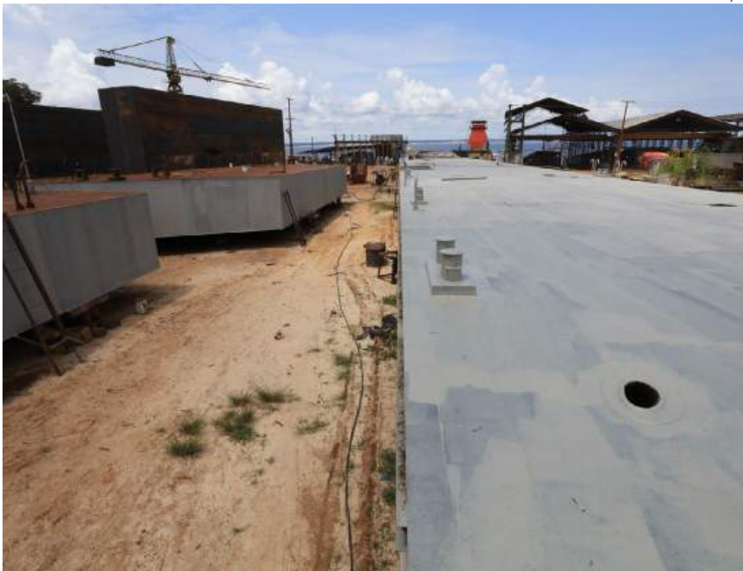
Primeiro Píer Turístico da capital amazonense recebendo etapa de pintura e tubulação
