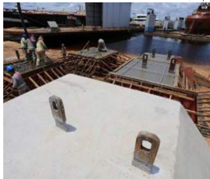
Estrutura metálica vai compor mirante Lúcia Almeida
