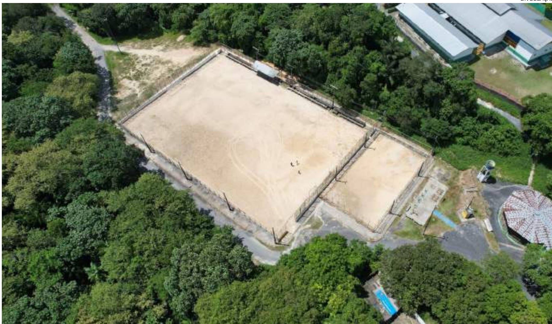
Campo de mais de sete mil metros quadrados está há 20 anos sem receber intervenção na estrutura
