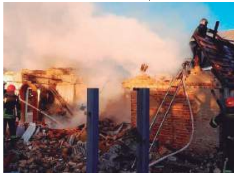
Bombeiros trabalham contra incêndio após ataque com mísseis russos
