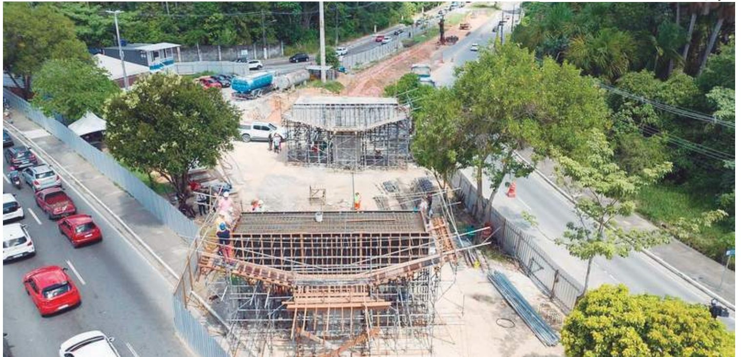
Dos seis pilares que vão dar sustentação em pontos estratégicos do viaduto, quatro blocos foram concretados
