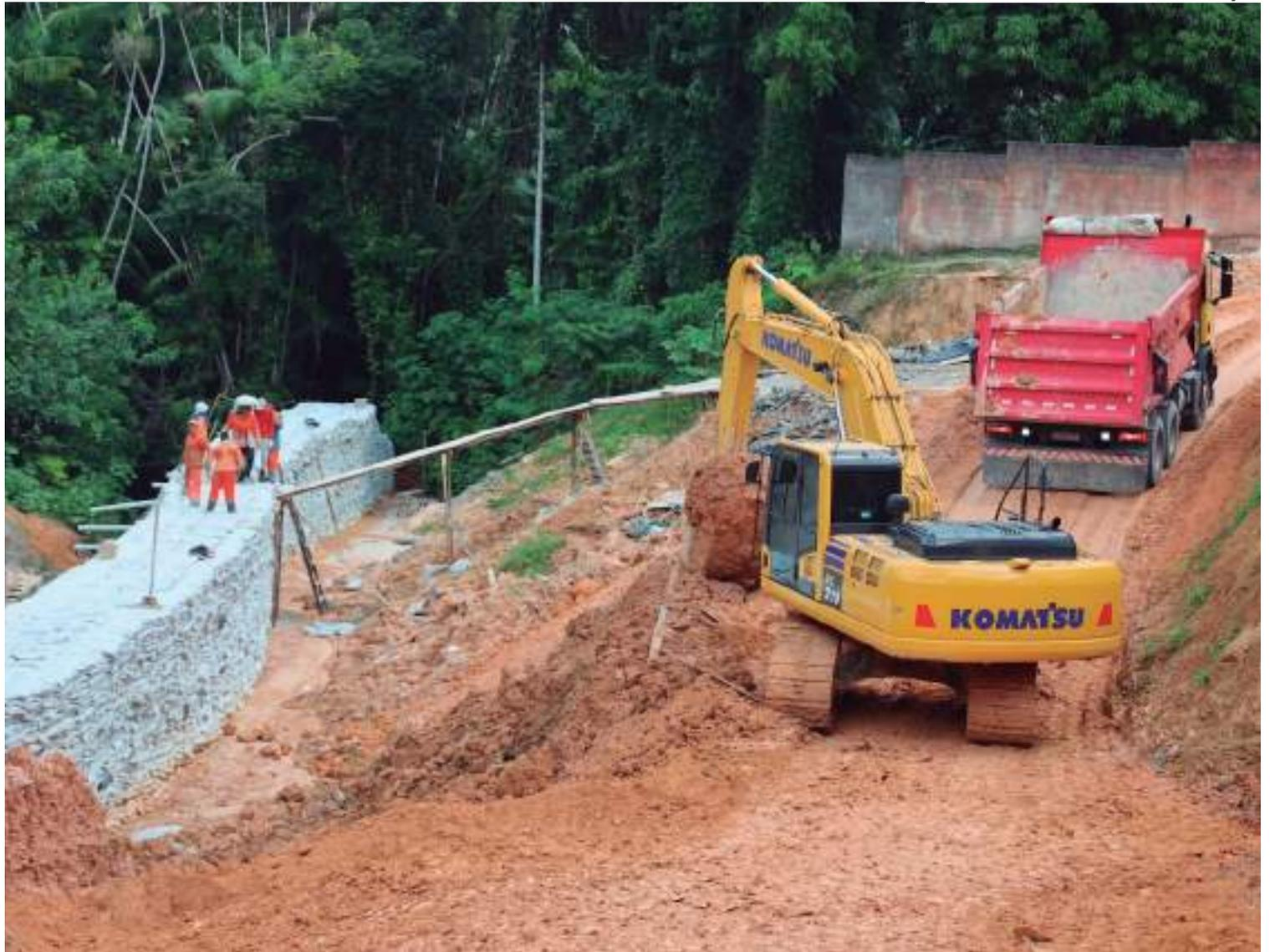
Trabalhadores concluem contenção em rip-rap em uma linha de 100m de comprimento nas laterais do igarapé
