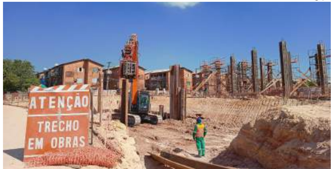
Obra é um dos empreendimentos do Trata Bem Manaus
