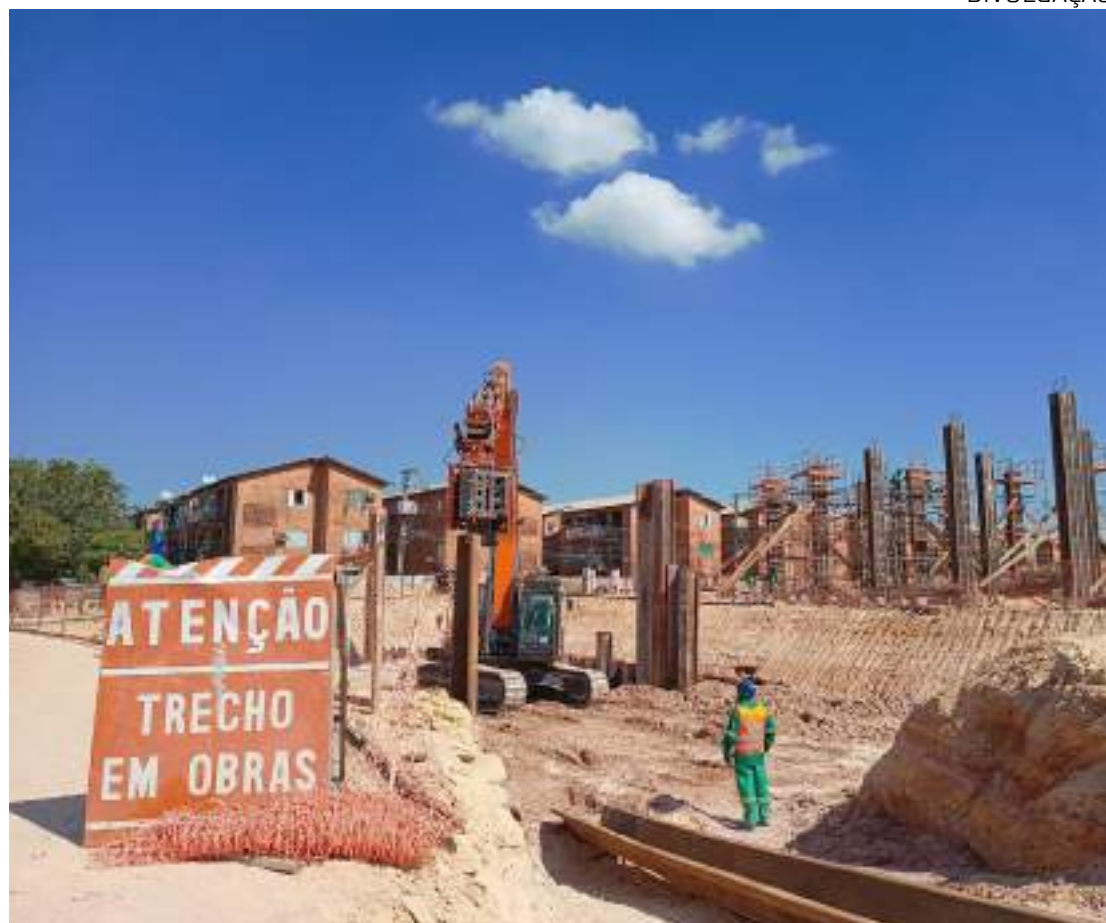
Obra é um dos empreendimentos do Trata Bem Manaus, programa em prol do tratamento de esgoto
