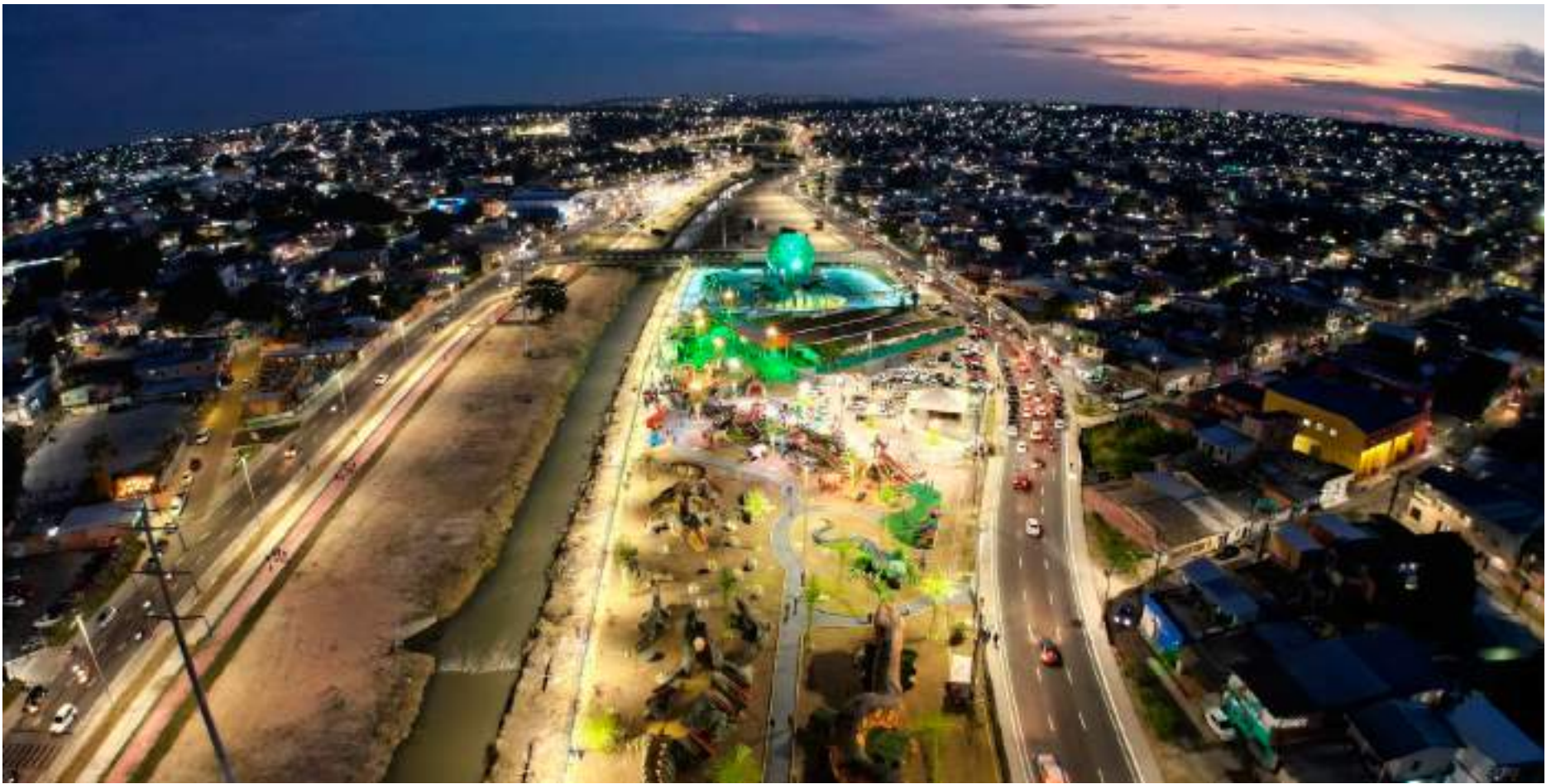
Construção apresenta seis cenários interativos temáticos, com rampas de escalada, escorregadores, área molhada, entre outros
