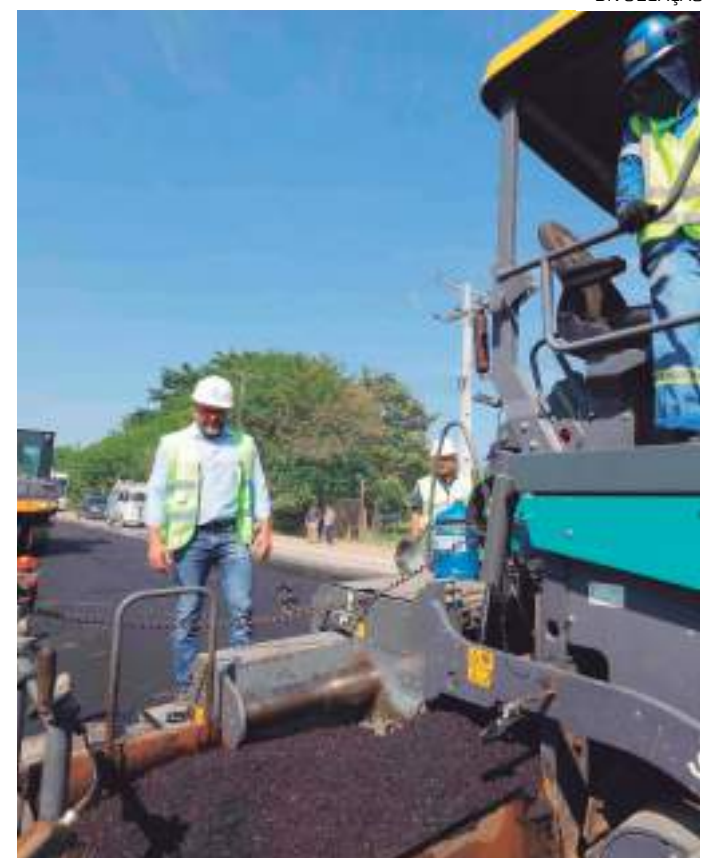
Obras da rodovia já alcançaram 60% de conclusão em julho
