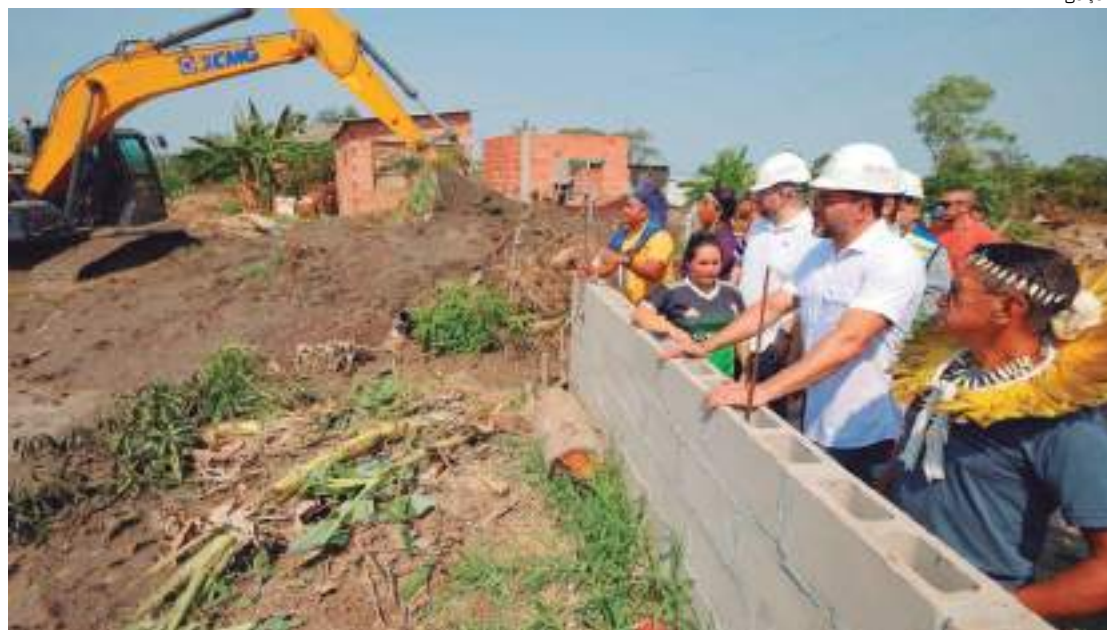
Governador Wilson Lima deu início, em julho, à nova etapa de obras e serviços do Asfalta Amazonas
